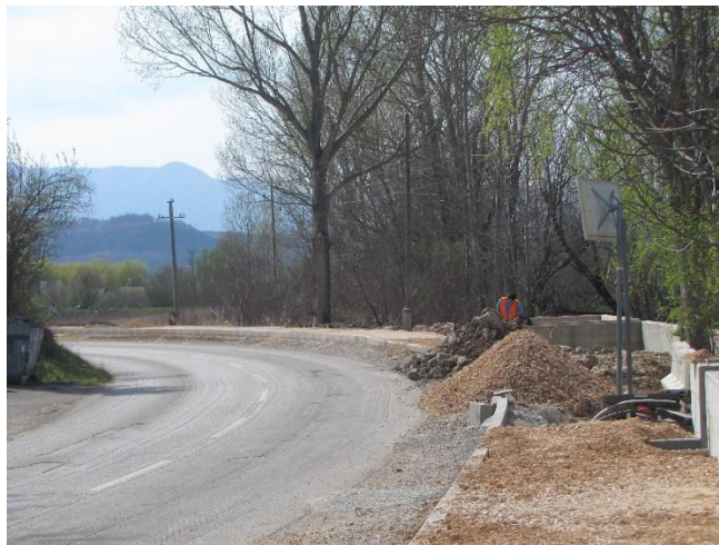
Slika 3. Postavljanje kandelabera za javnu rasvjetu
