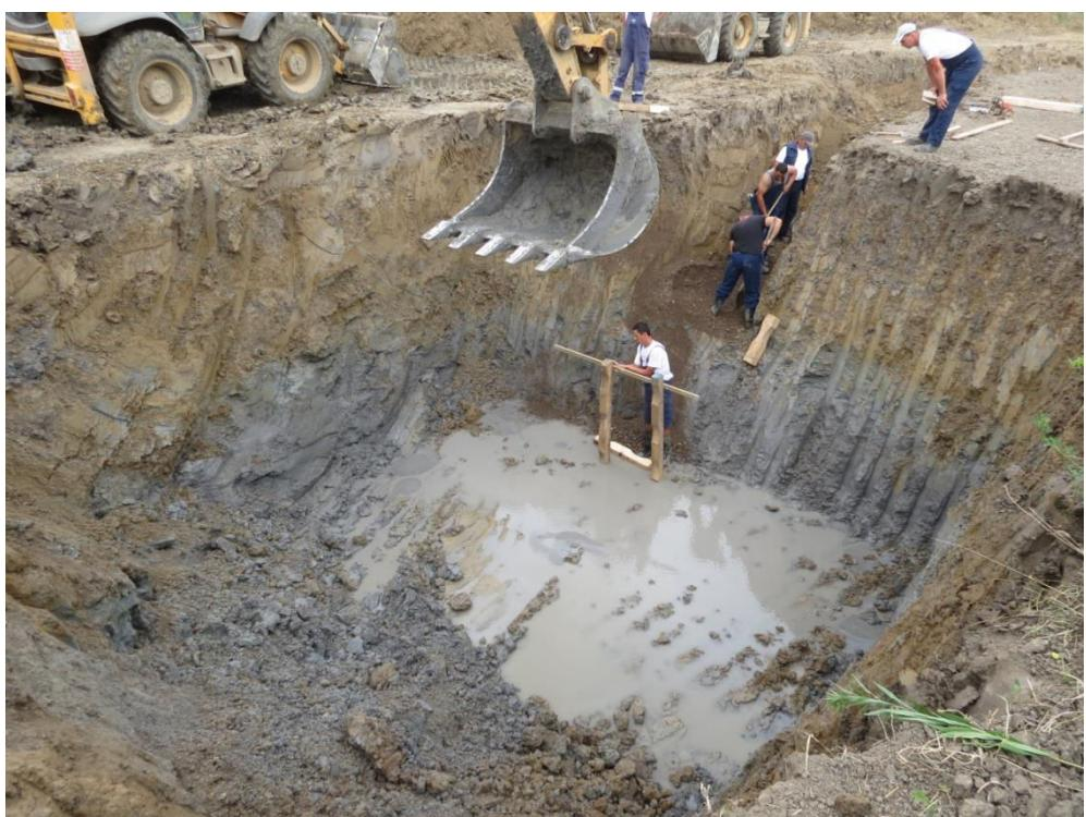
Slika 9: Iskop šahte za muljni ispust. Vidljiv je sloj sivog pijeska SJ 04 ispod sloja SJ 02
