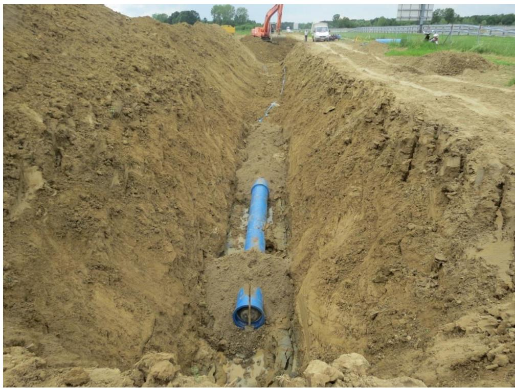
Slika 20: Ljevkasti oblik iskopnog rova u presjeku. Pogled prema zapadu
