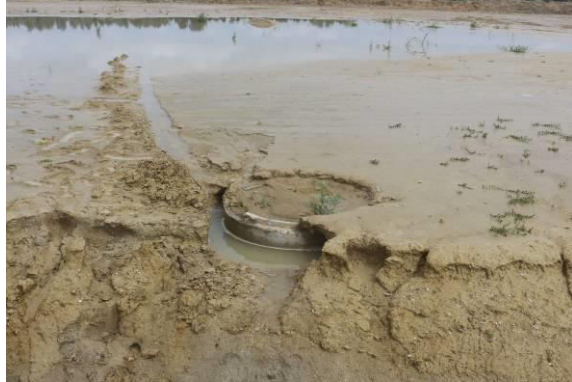
Slika 8: Bunar od betonske cijevi
