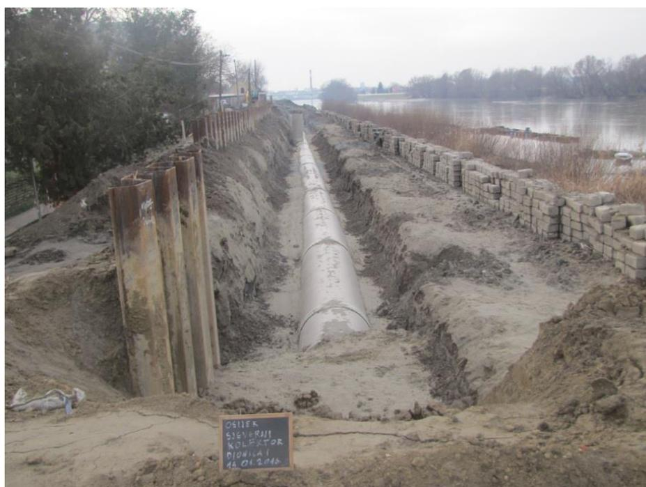
Slika 7; Dionica I nakon postavljanja cijevi segmenti od ST 0+600 do ST 0+790,00
