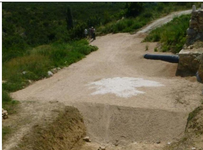
Slika 12. Dobava i ugradba jalovine iznad drvene konstrukcije, kao završna zaštita lokaliteta.
