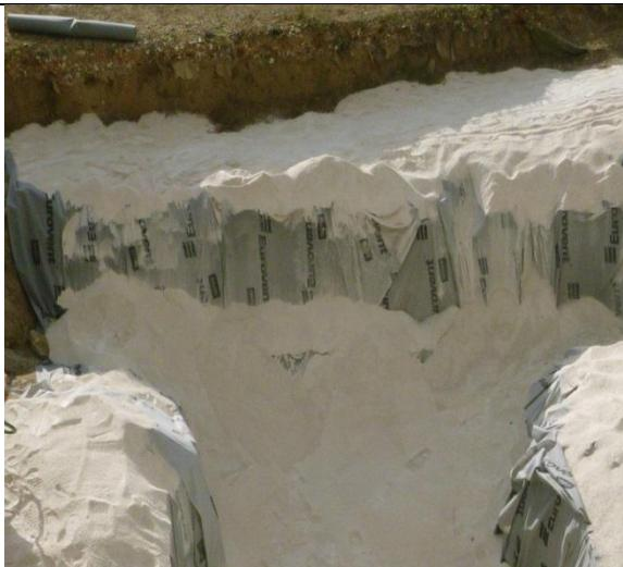
Slika 6. Zaštita geotekstila slojem kamenog pijeska debljine 30 cm (u cijenu uključen prijevoz ručnim kolicima 20m).
