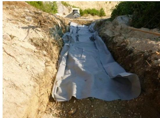
Slika 15. Geotekstil ispod polupropilenskih cijevi
