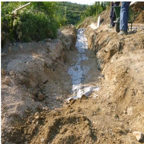
Slika 16. Dobava i ugradba sloja jalovine prosječne debljine 80 cm u podu kao priprava za polaganje polupropilonskih cijevi  $\varnothing$  800 mm te dobava i ugradnja cijevi
