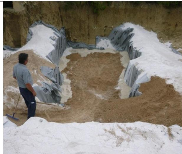
Slika 7. Dobava jalovine i nasipanje do vrha zidova objekta (u cijenu uključen prijevoz ručnim kolicima 20m), a uz geotekstil svugdje je postavljan pijesak (0).
