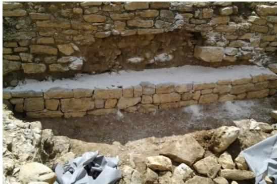
Slika 4. Zidanje i konzerviranje dijela zida u vapnenom mortu, zidanje potpornog suhozida te izlaza produžetka oborinske cijevi
