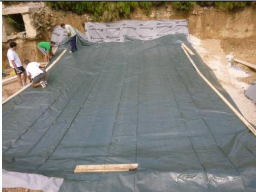
Slika 10. Postava najlona iznad geotekstila
