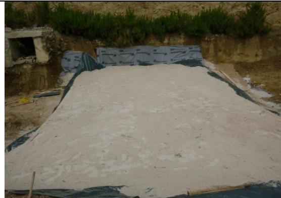
Slika 11. Zasipanje pijeskom (0) debljine 20/30 cm, iznad najlona, geotekstila i dasaka
