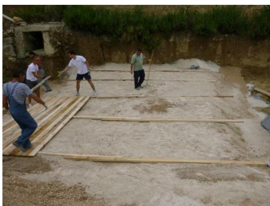
Slika 8. Dobava i postava konstrukcije od drvenih dasaka i greda 24 mm
